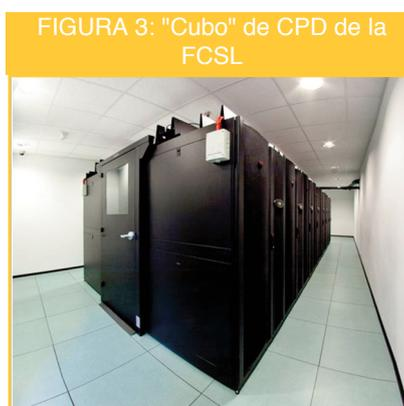
La separación de ambientes y la confinación del aire caliente, mejoran sustancialmente el funcionamiento del sistema
